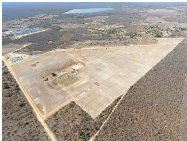
BJL 4 Solar en construction (PC: Biosar)
