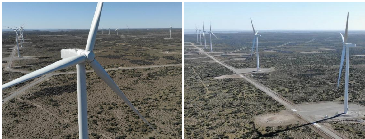
La centrale éolienne de “Malaspina”
